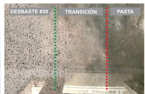
Desbaste superficial con disco metálico, utilizando Kick Start y riego de la superficie del piso. Este procedimiento es realizado continuamente en varias pasadas extendiendo, cepillando y limpiando la superficie con el liquido formado por Kick Start.
