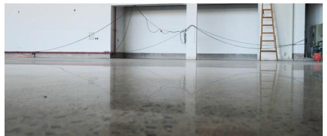
Abrillantado con discos #800 y #1500 en pasadas transversales, limpieza de la superficie y abrillantado final con maquina burnisher.
