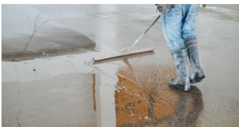
Aplicación de RETROPLATE sobre la superficie del piso de hormigón, dejar reposar, después del reposo limpiar todo excedente del producto.
