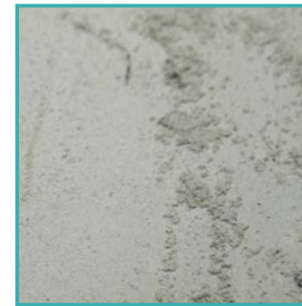
Cuando se raya con un objeto de metal, el concreto no densificado se desgasta y se empolva fácilmente. El hormigón densificado y pulido ayuda contra la erosión y el desgaste, pero no puede prevenirlo por completo.
