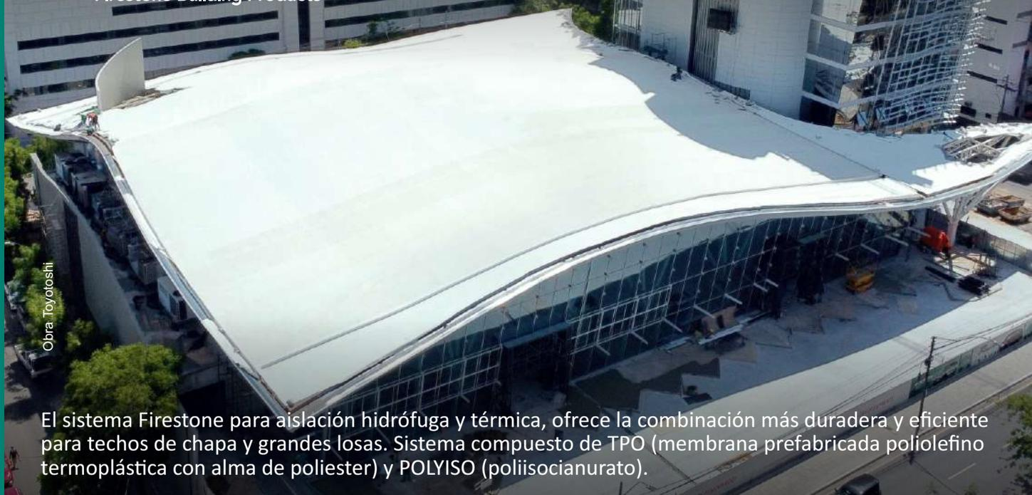
El sistema Firestone para aislación hidrófuga y térmica, ofrece la combinación más duradera y eficiente para techos de chapa y grandes losas. Sistema compuesto de TPO (membrana prefabricada poliolefino termoplástica con alma de poliéster) y POLYISO (poliisocianurato).
